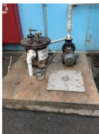
▲ 損壞馬達修繕完成
